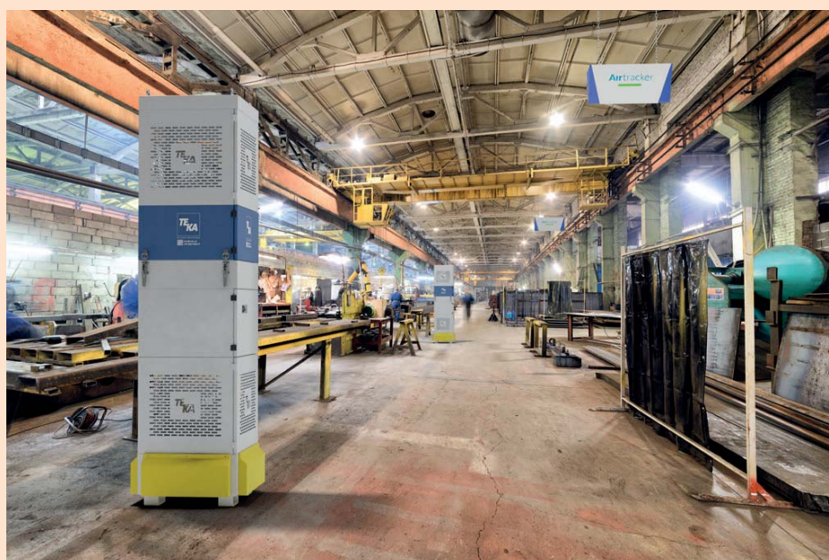
Exemple d'application CleanAirCubes avec Airtrackers
